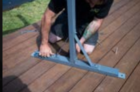
STEP 6: secure L-brackets per upright
